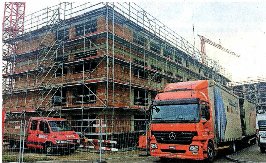
Die beiden vierstöckigen Gebäude stehen im Rohbau.
